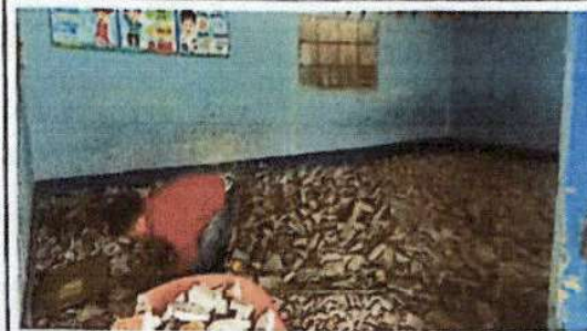
Foto 4: Arreglando Piso en mal estado
