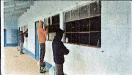
Foto 2: Arreglando Vidrios en mal estado
