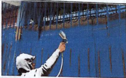
Foto 3: Arreglando Balcones en mal estado
