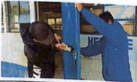
Foto 1: Arreglando Chapas en mal estado
