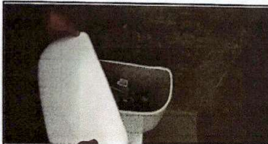
Foto 5: Arreglando Inodoros en mal estado
